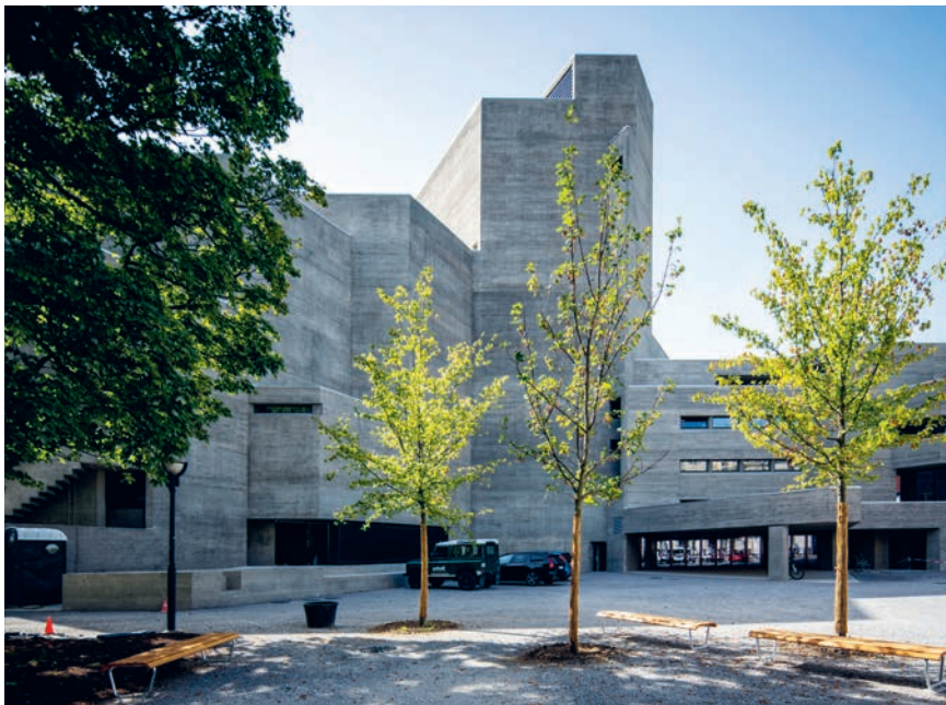
Das Theater St.Gallen nach der Sanierung.
