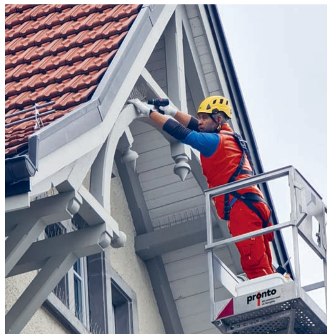
Montage von Taubenspikes mithilfe einer Hebebühne.
