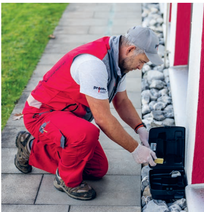
Montage einer Köderbox zur Schädlingsabwehr.
