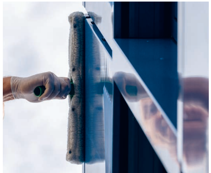
Versiegelung der Aluminiumfassade
