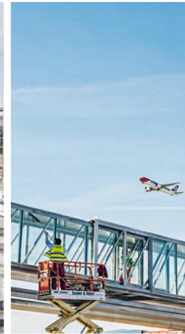
Fassadenreinigung auf höchstem Niveau.
