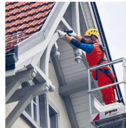
Montage von Taubenspikes mithilfe einer Hebebühne.
